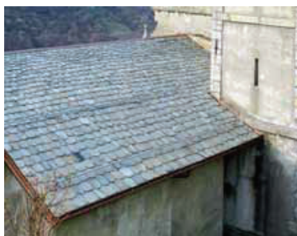
Bidogno (Capriasca), Chiesa parrocchiale di San Barnaba, particolare del tetto. Dopo il restauro.
